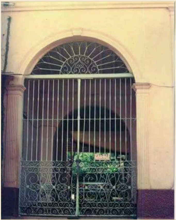
Fig. 4 • Portón principal: arco, pilastras y herriería forjada.
